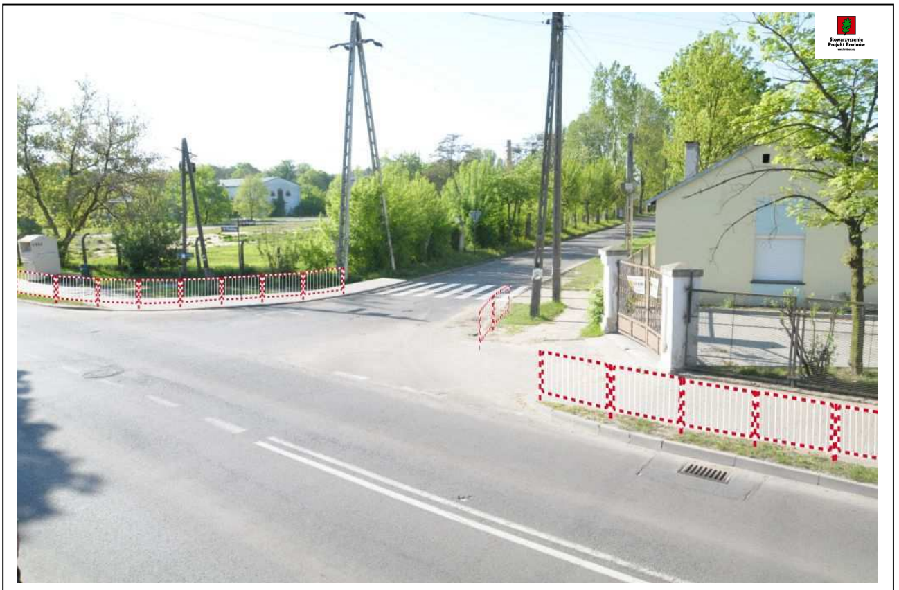
Fot. 10. (8647) Widok skrzyżowania ul. Przejazd z ul. Piłsudskiego. Zdjęcie wykonane od strony skrzyżowania z ul. Szkolną. Wrysowano koncepcję budowy chodnika, lokalizacji przejścia dla pieszych oraz montażu ogrodzenia segmentowego.
