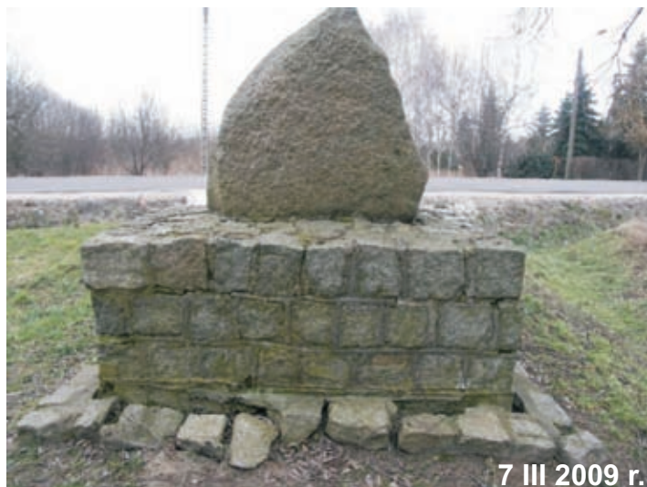
stan przed remontem
