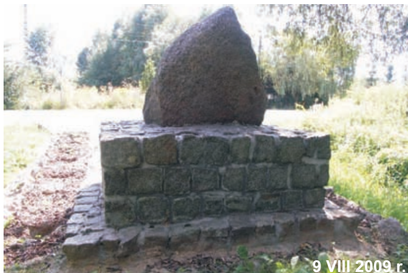
stan po remoncie
