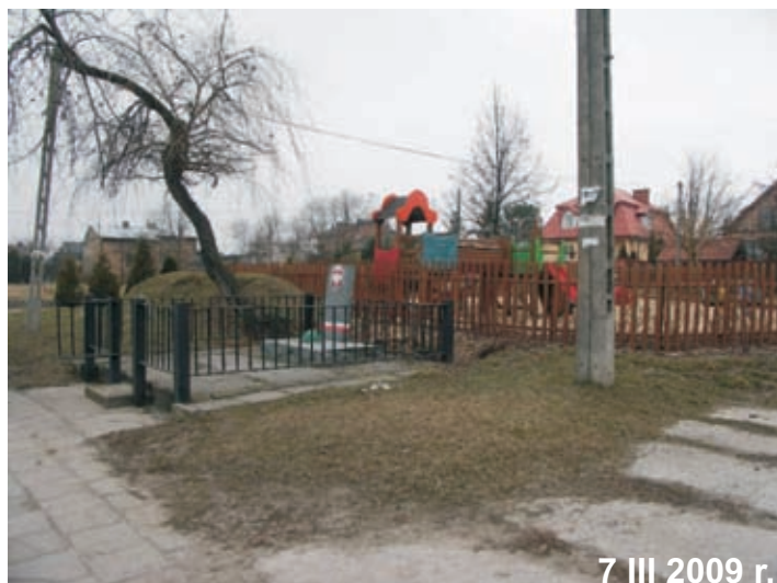
stan przed remontem
