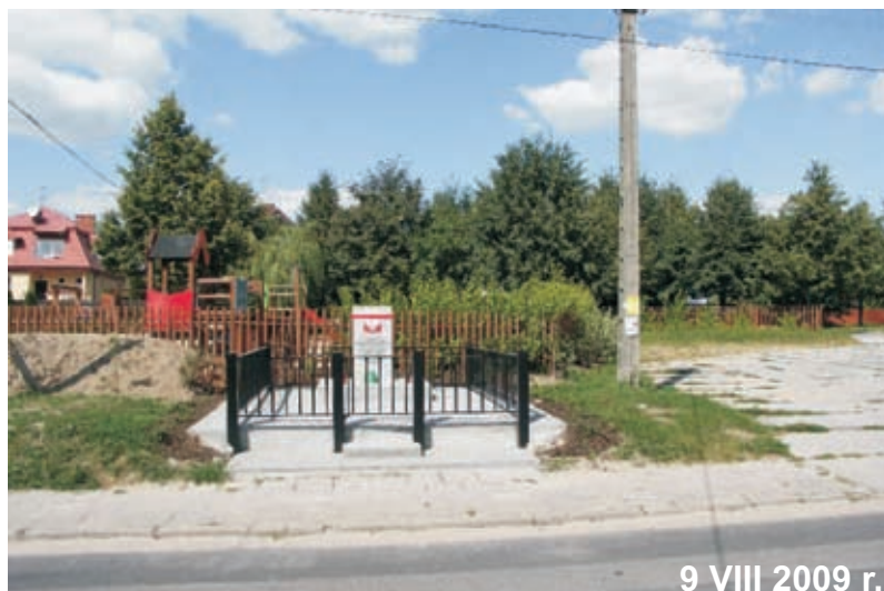
stan po remoncie
