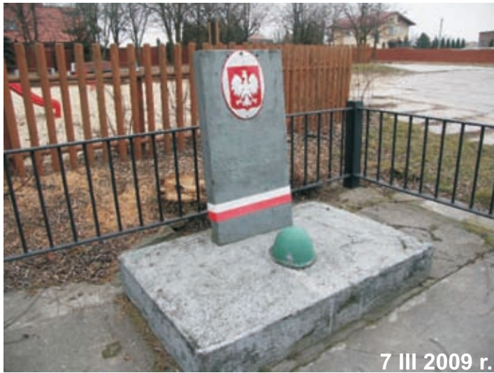
stan przed remontem
